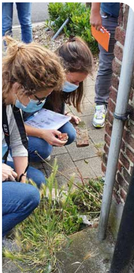
Inspectie van stenen en mortel tijdens de inventarisatie.
